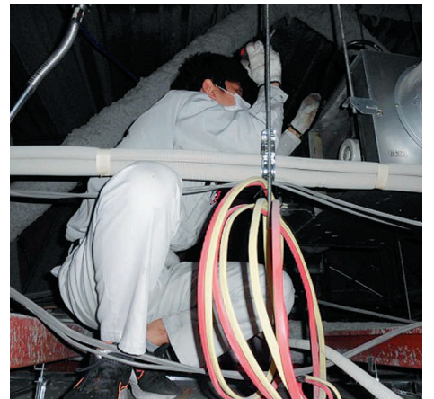
▲天井内で空調設備を修理しています
